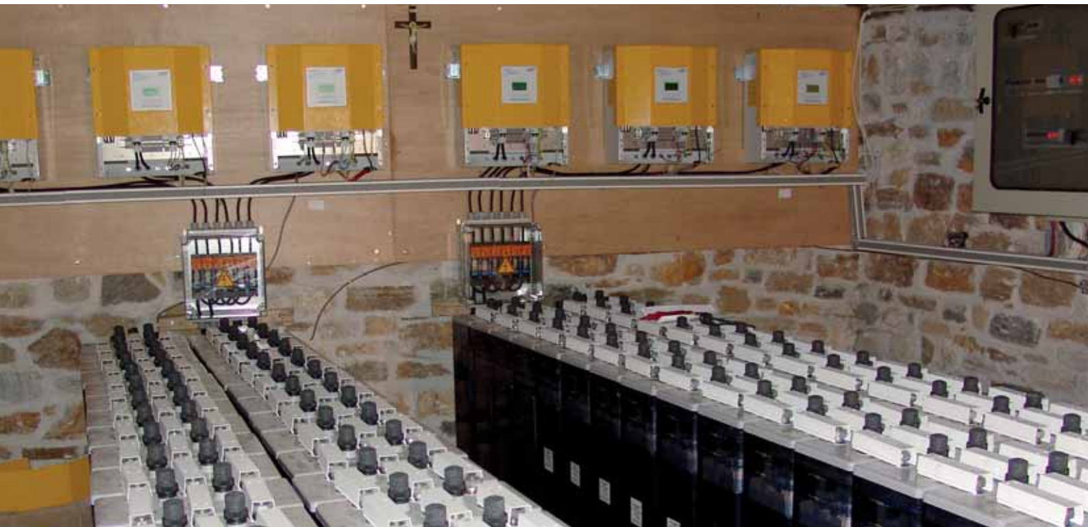
Inselsystem, bestehend aus Sunny Island Batteriestromrichtern und Batterien auf dem Berg Athos in Griechenland
